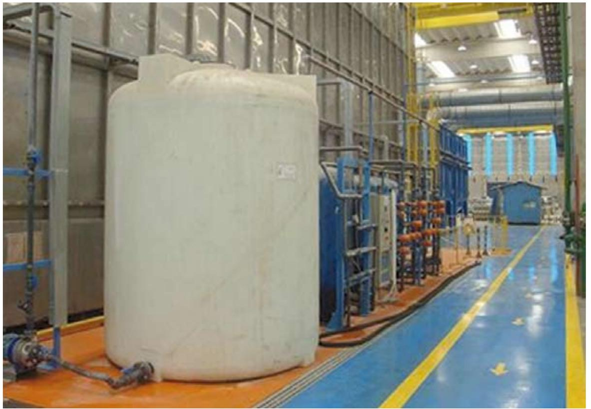
**15 - L'impianto di trattamento delle acque reflue di fosfocromatazione.**
