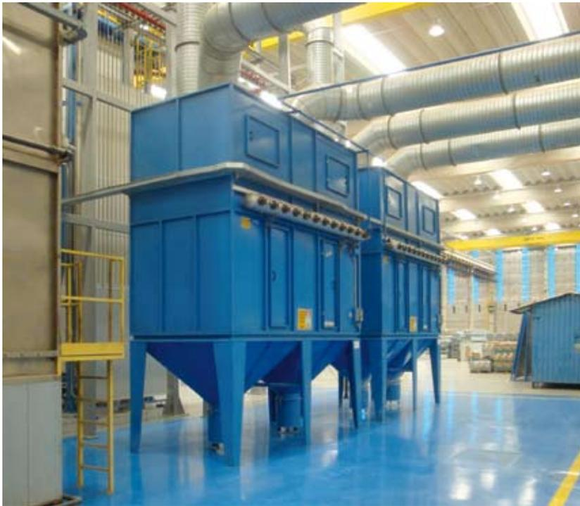
12 - I filtri di recupero finale delle polveri e dell'aria perfettamente pulita: le loro dimensioni danno bene l'idea del "gigantismo" produttivo di questa industria di verniciatura profili in alluminio.
